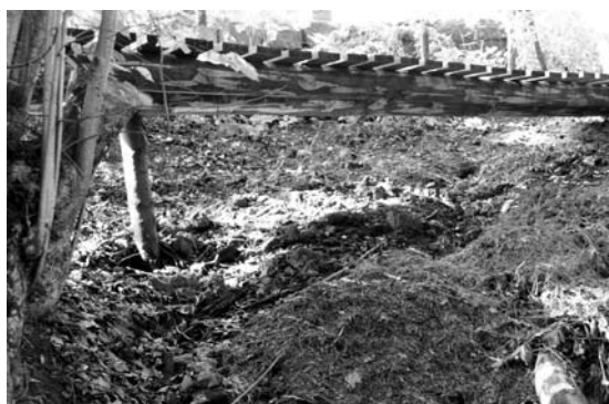
Holzgitter und Rasenschnitt über die Brücke gekippt
